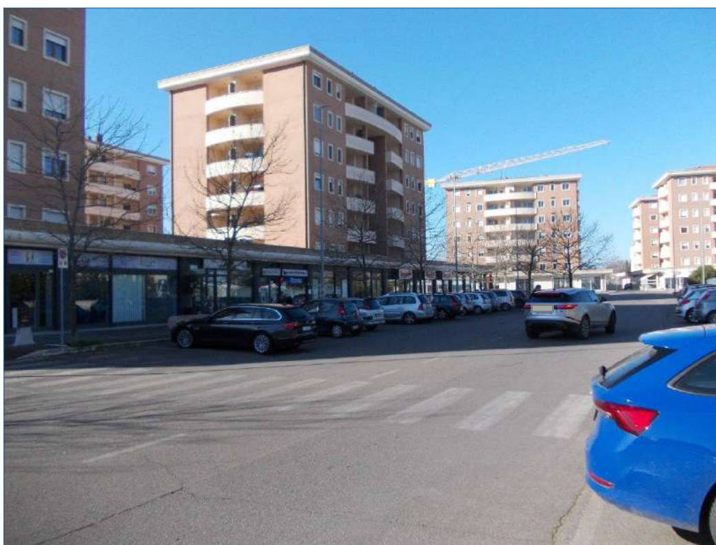
Foto 2. Vista esterna complesso immobiliare da Via Luigi Galvani
