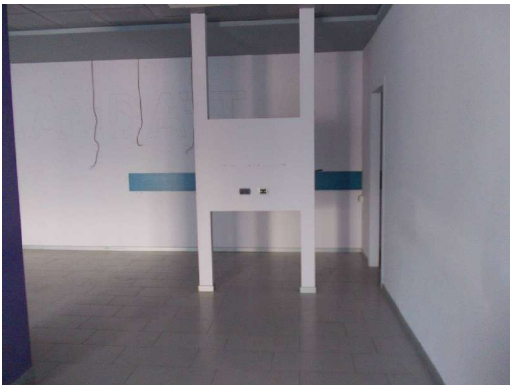
Foto 18. Interno locale principale
