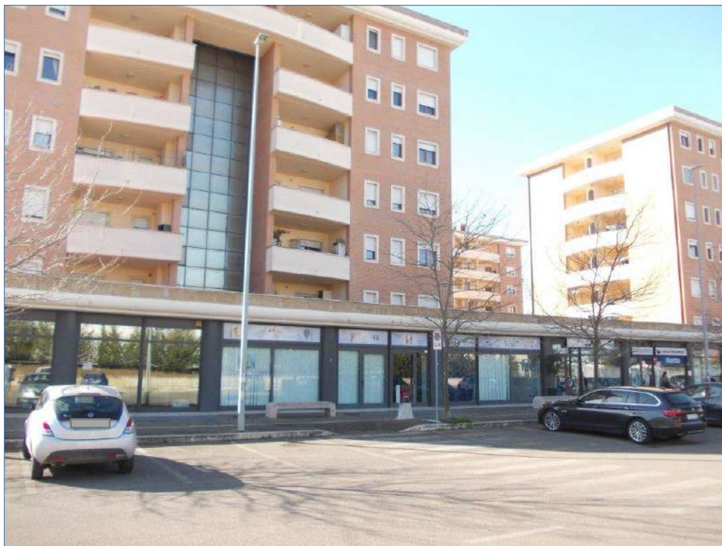
Foto 1. Vista esterna complesso immobiliare da Via Luigi Galvani
